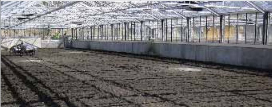
Acht brandneue solare Trocknungsanlagen beweisen: Unser Weg ist der richtige
