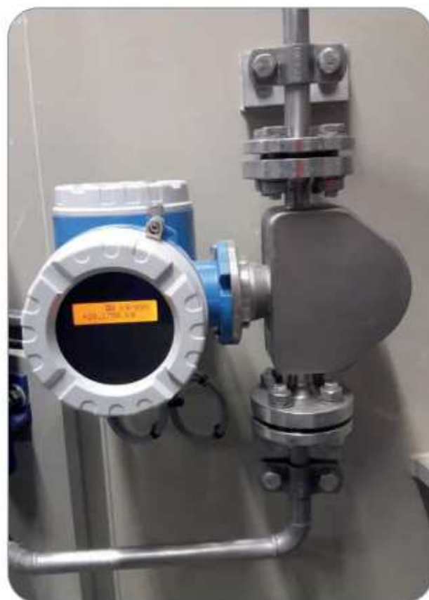
Detail der Polymerlösestation AWV Grazerfeld
