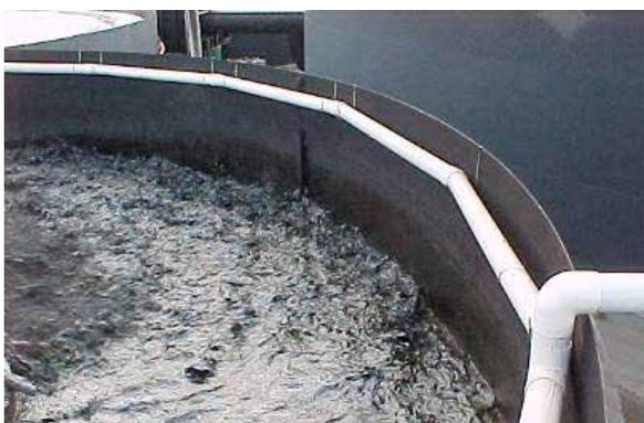
Ecosorb® Vapour Phase Equipment usato intorno a un grande laghetto di decantazione
