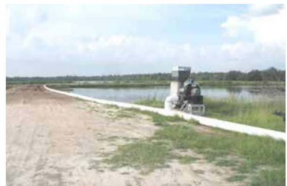
Ecosorb® Dampf Verteilung bei Absetzbecken in einer Raffinerie
