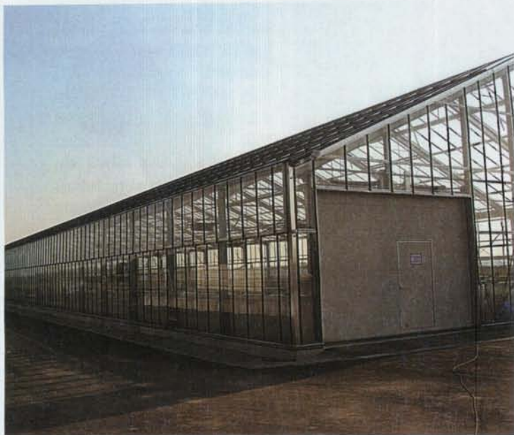
Solare Schlamm-trocknung auf der Kläranlage Ebreichsdorf.
